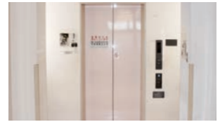
本館のエレベータ (緊急用)
